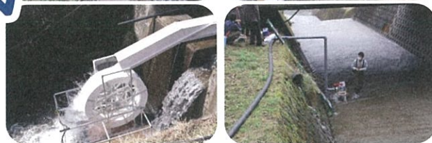
現地での設置状況 (2015年3月22日 第4回 愛知県豊田市)
